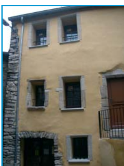
Réhabilitation d'une maison sur le Pays
